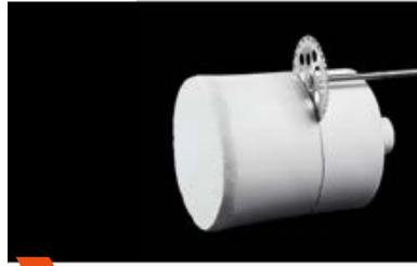
**2** Faça um corte circular e profundo no material de revestimento ao longo da marcação.
